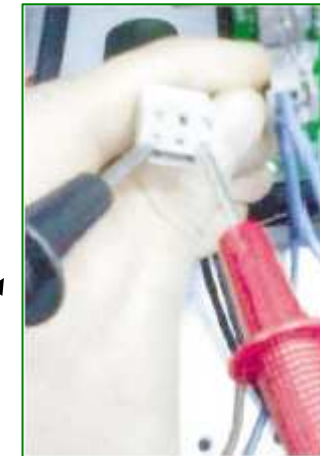
Vérification état contact pressostat
